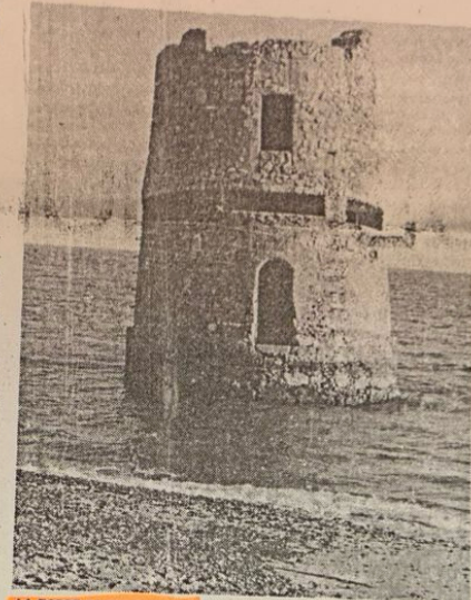
LA TORRE DI CARCANGIOLU, PRIMA DEL CROLLO. (FOTO ED.)
